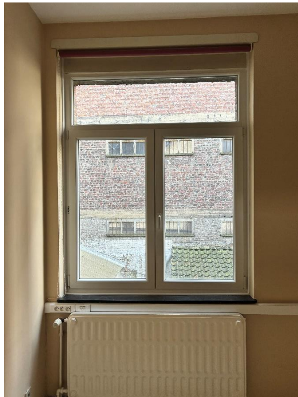
Forme de châssis modifié récemment (modifications ponctuelles : modèle des 3 châssis remplacés au 1 er étage arrière gauche)
